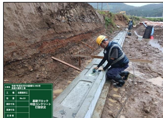
護岸の基礎ブロックの施工が始まりました。
