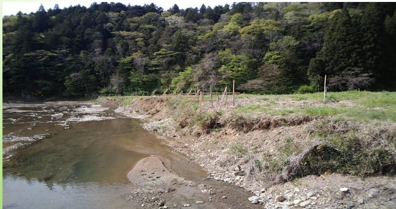
護岸ブロックの丁張を設置しました。
