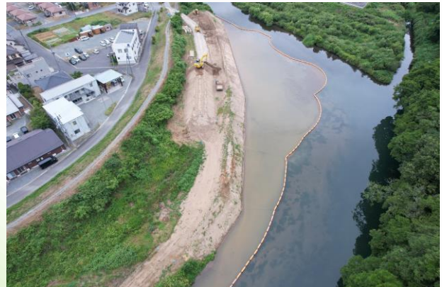
河川の堆積土砂掘削が完了しました。
