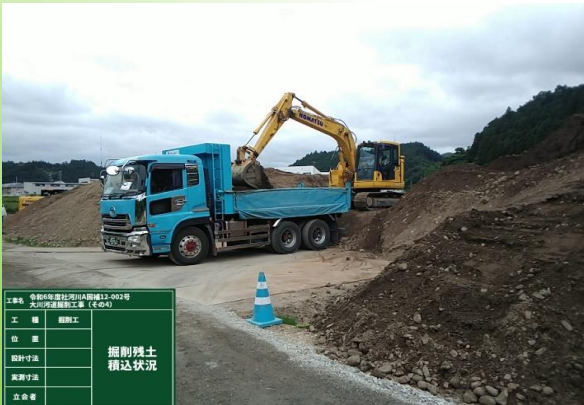
掘削した土砂を搬出しています。
